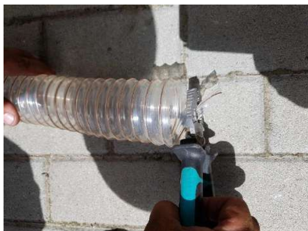
39-40. Kép - A pellet csövet méretre kell vágni, úgy, hogy ne legyen benne olyan rész, ahol a pellet meg tud állni (túl kis sugarú kanyarulat, hupli stb. ki hogyan hívja)
