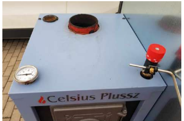
35. Kép – Ellenőrizzük, hogy az ajtó nyitása közben az égőfej ne akadjon meg a kazán oldalában, illetve az ajtó szélében
