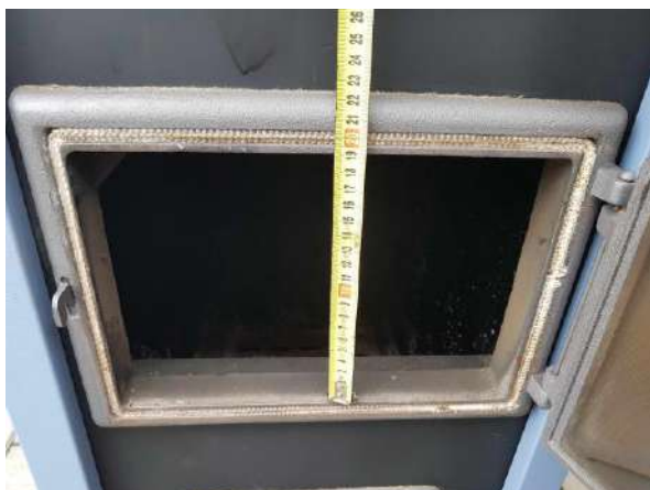
6. Kép – Fontos az égőfej felszerelhetőségéhez az ajtónyílás magassága is, ajánlott min. 200 mm
