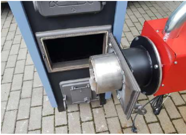
34. Kép – Az égőfej felszerelése után_4
