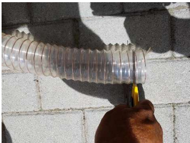
39-40. Kép - A pellet csövet méretre kell vágni, úgy, hogy ne legyen benne olyan rész, ahol a pellet meg tud állni (túl kis sugarú kanyarulat, hupli stb. ki hogyan hívja)
