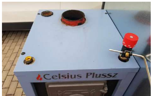
37-38. Kép – A kazán hőmérőjének merülő hüvelyt fel lehet használni a kazánhőmérséklet szenzor részére,
